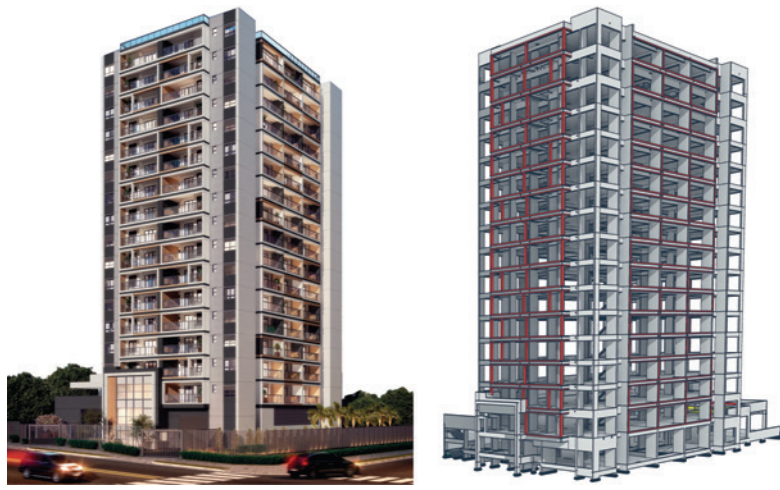
► Figura 11 Edifício Vision Capote Valente (Gafisa) – composição da fachada
